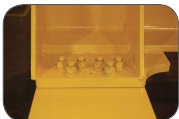
主端梁高强度螺栓连接
